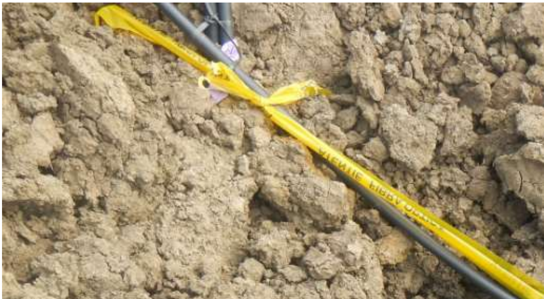
Figura 5. Model de pozare a unui cablu electric însoțit de panglica de avertizare
